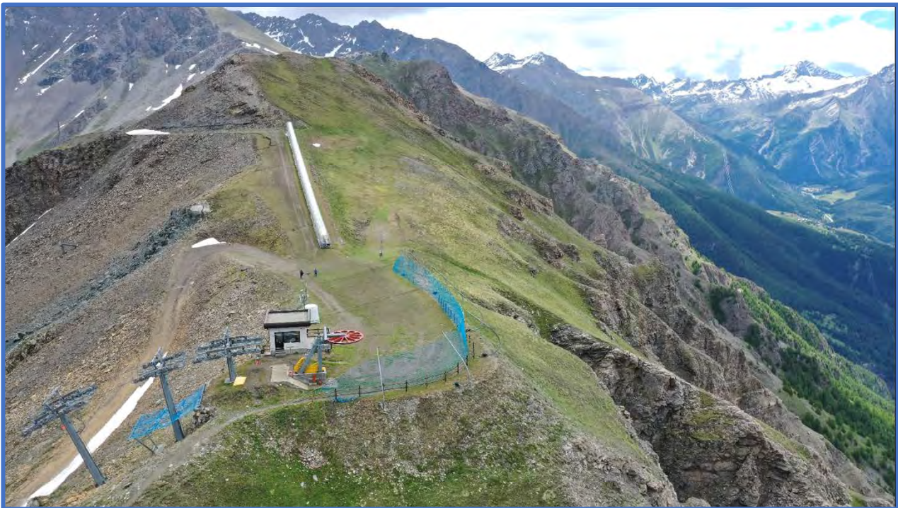
Punto di arrivo alla Platta de grevon sullo sfondo e in primo piano gli impianti che saranno dismessi Immagine tratta dalla Relazione generale del Progetto fornita da Alpteam
