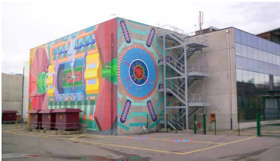
Atlas Control Room (CERN di Ginevra)
